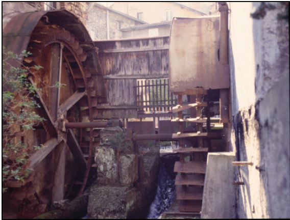
Ecluse n°1 (Navaron) : roues jumelées.
